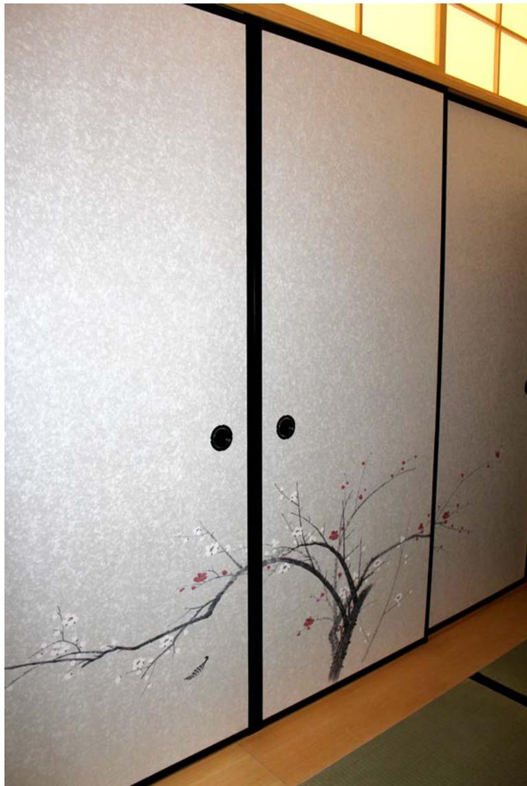
FUSUMA laufen traditionell in einer Konstruktion aus Holzführungsschienen oben und unten. Zur Verbesserung der Laufeigenschaften wird die untere Schiene traditionell mit farblosen Wachs behandelt oder, wie meist mit einem holzfarbenen Gleitband aus PVC versehen, welches in Japan eigens für diesen Zweck entwickelt und hergestellt wird
