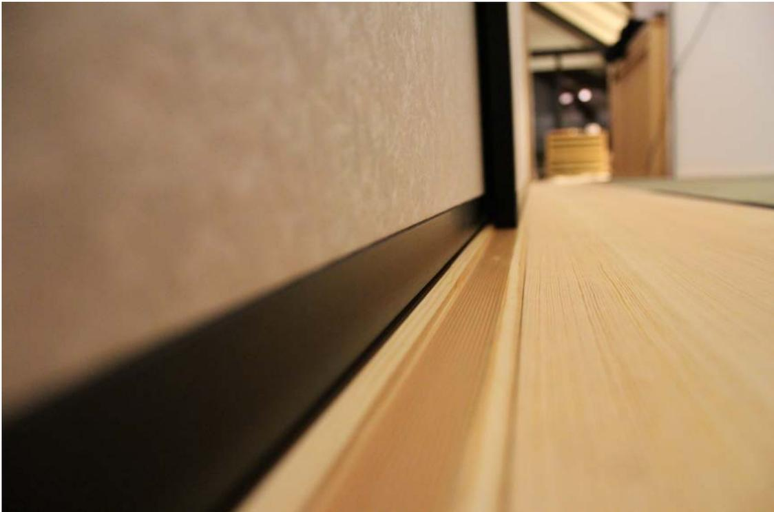
Eine FUSUMA-Konstruktion, insbesondere der Aufbau der Schienenführung unterscheidet sich nicht wesentlich von der einer SHOJI-Anlage. Die Basis bildet auch hier ein Gitterwerk, welches aus gefasteten Sprossen besteht, die von einem äußeren, abnehmbaren Holzrahmen gehalten werden, welcher farbig, meist schwarz abgesetzt wird. Somit kann das Papier wieder ausgetauscht werden, ohne den gesamten Rahmenaufbau zu zerstören.
